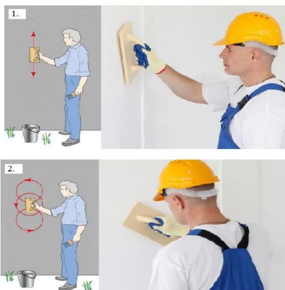
Выполнение затирочных работ
