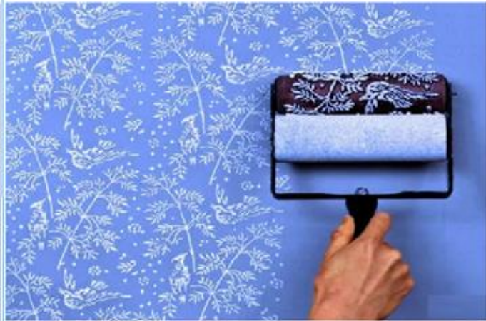
Отделка поверхностей узорным валиком
