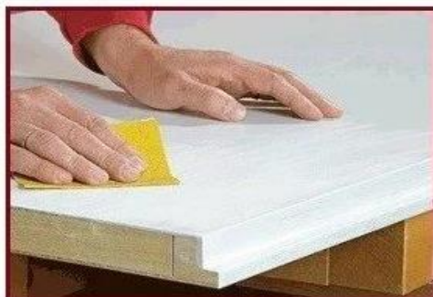
Шлифуем грунтовочный слой краски бумагой.
