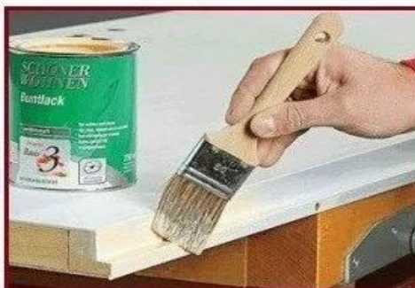
По грунту наносим декоративную краску.
