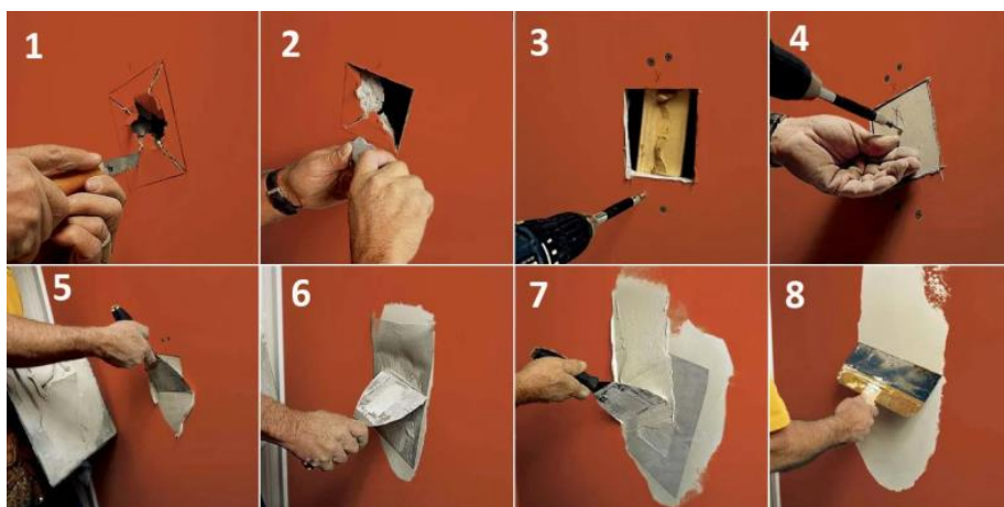
Технологическая карта ремонта поверхности, отделанной гипсокартоном
